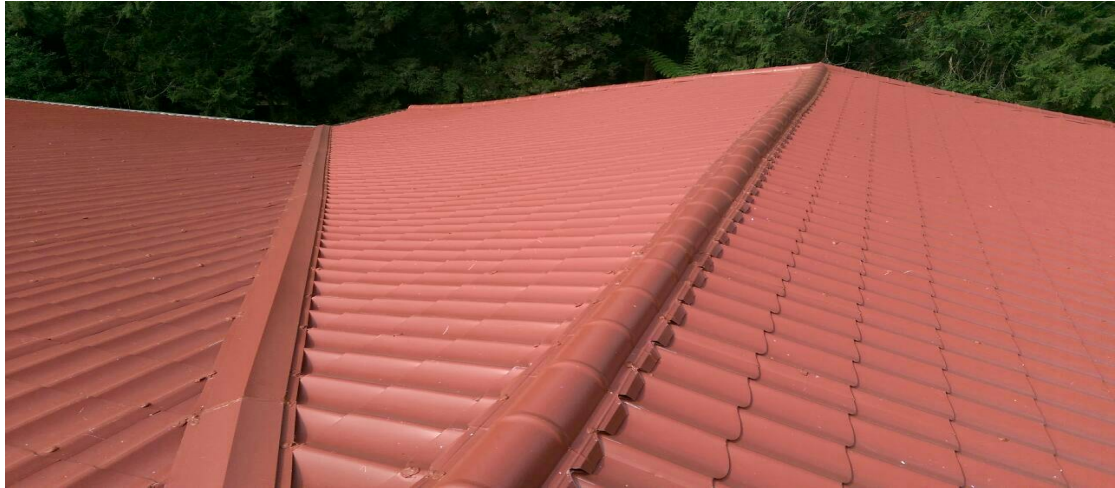
屋頂竣工照片
