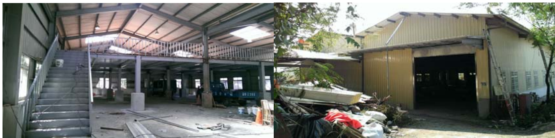
工廠倉儲車房整修工程
