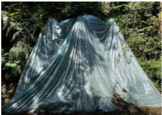
溪頭營林區「大學池林道邊坡土石裸露」施工前
