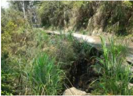
溪頭營林區大學坑透水柵土石清理前
