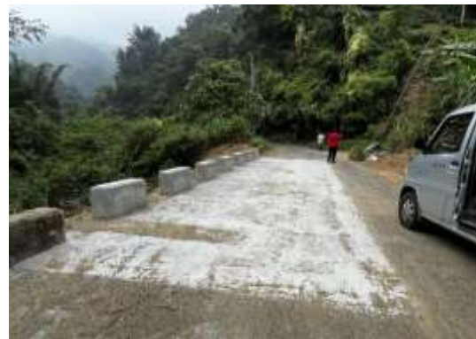
清水溝營林區「坪溪湖林道路基沖蝕掏空」施工後
