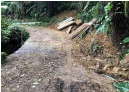
清水溝營林區12林班田坪山農路路基 掏空施工前
