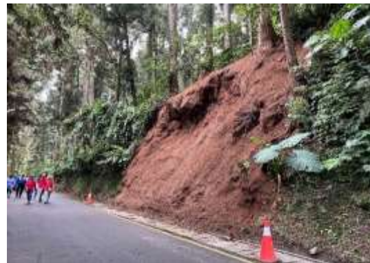
溪頭營林區「大學池林道邊坡土石裸露」施工後
