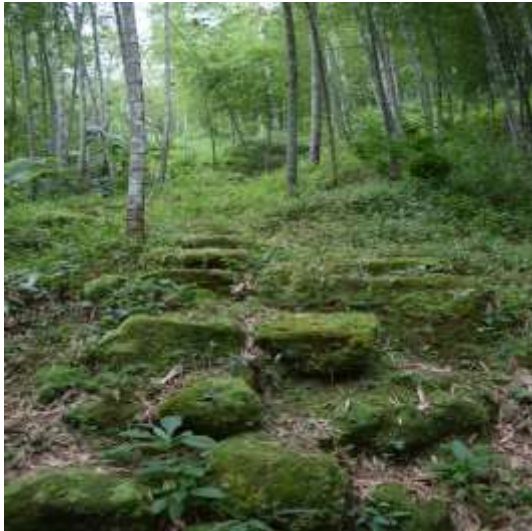
八通關古道路基
